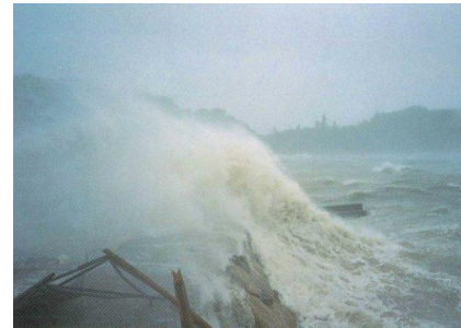
高波による被害写真 (国土交通省より)
