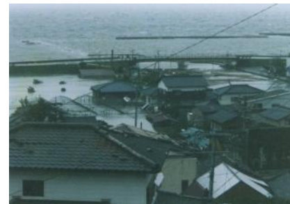
高潮による被害写真
